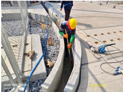
รูปที่ 21 การขุดลอกตะกอนจากรางระบายน้ำ ภายในพื้นที่ก่อสร้าง
