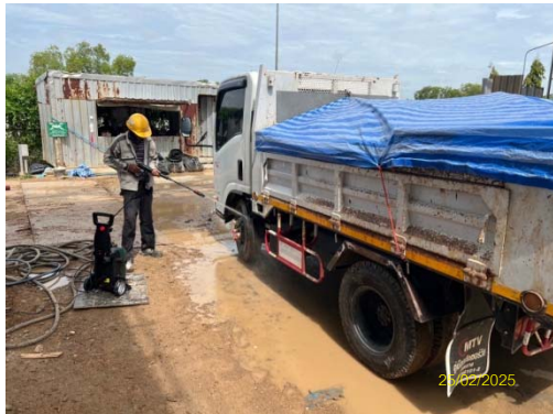
รูปที่ 2 การปิดคลุมรถขนส่งวัสดุก่อสร้าง
