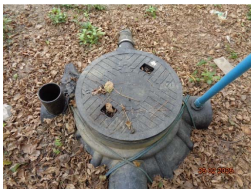
รูปที่ 9 ระบบบำบัดน้ำเสียสำเร็จรูป
