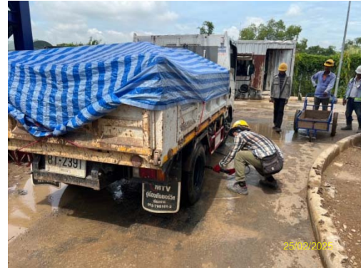
รูปที่ 2 การปิดคลุมรถขนส่งวัสดุก่อสร้าง
