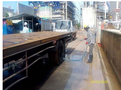
รูปที่ 4 การล้างล้อรถบรรทุกก่อนออกจากพื้นที่ก่อสร้าง
